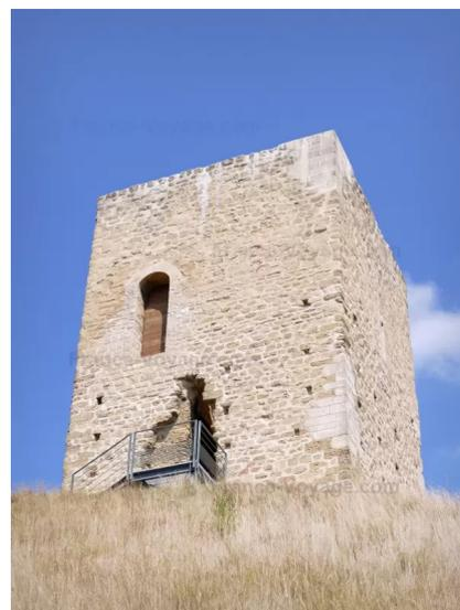
Des trous de boulins sont nettement visibles dans la moitié inférieure des murs. il s'agit des logements dans lesquels étaient enfoncées les poutres ou boulins qui supportaient l'échafaudage des maçons lors de la construction.
